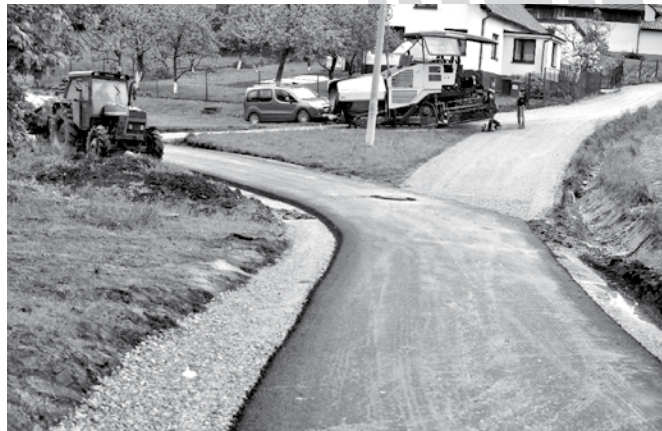
Remont ul. Rzecznej
