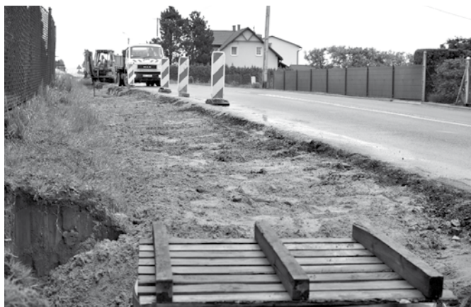
Budowa chodnika przy ul. Witosa
